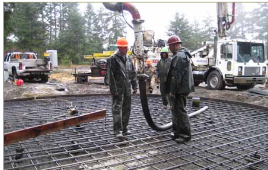
Concrete pour for the water storage tank.
